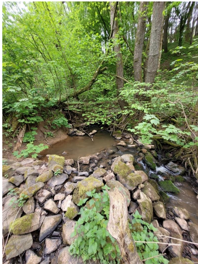
Abbildung 4: Aufgelöste Steinschüttung mit Verbau von Holzschwellen nahe der Theelmündung, die keine optimale Durchwanderung gewährleistet, diese aber (bei hohen Wasserständen) auch nicht verhindert (Foto: N. Wagner).
