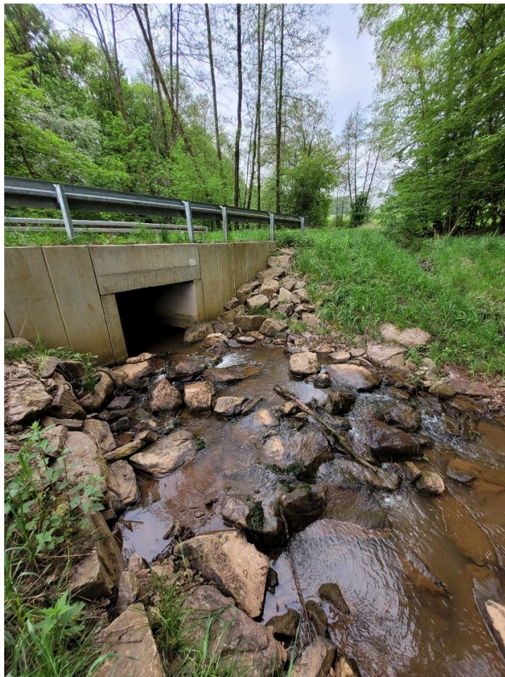
Abbildung 1: Vorher: Verrohrung des Dörrbachs unter einem Feldwirtschaftsweg, welche die Durchgängigkeit verhinderte (oben), nachher: Fischrampe mit versetzten Becken, welche einen Fischaufstieg ermöglichen (unten) (Fotos: N. Wagner, 2020 und 2024)
