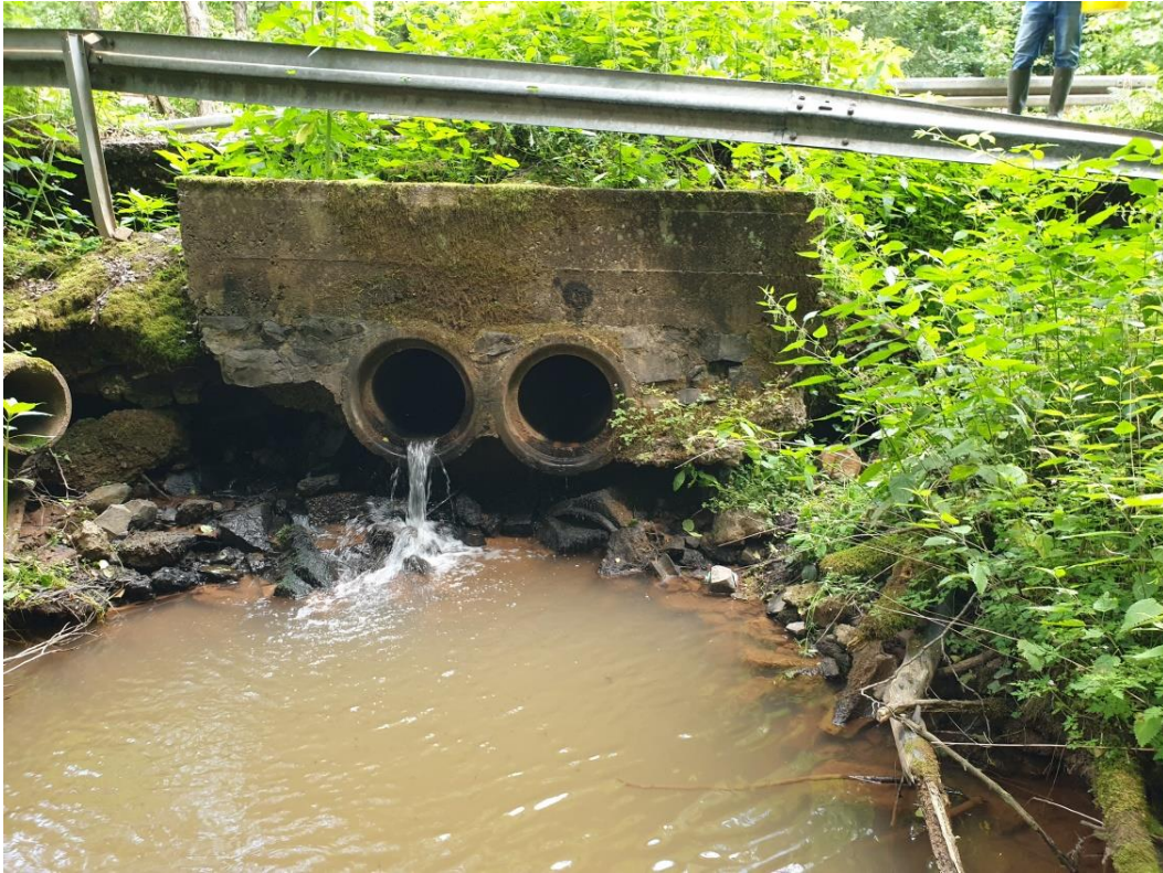
Abbildung 1: Verrohrung des Dörrbachs unter einem Feldwirtschaftsweg, welche die Durchgängigkeit verhindert (49.451475, 6.981292) (Foto : N. Wagner)
