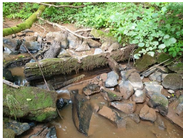
Abbildung 4: Aufgelöste Steinschüttung mit Verbau von Holzschwellen nahe der Theelmündung, die keine optimale Durchwanderung gewährleistet. (Fotos: N. Wagner)
