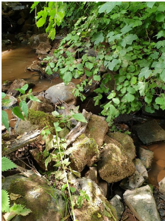
Abbildung 4: Aufgelöste Steinschüttung mit Verbau von Holzschwellen nahe der Theelmündung, die keine optimale Durchwanderung gewährleistet. (Fotos: N. Wagner)
