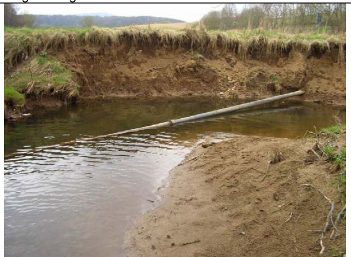
freigespülte Wasserleitung durchquert Gewässer
