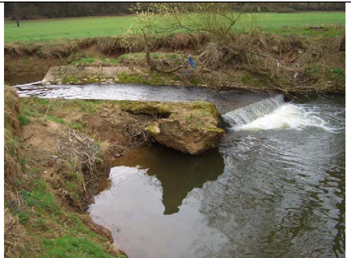
Absturz durch Querung Abwassersammler mit Eintiefung der Stelle unterhalb Sammler
