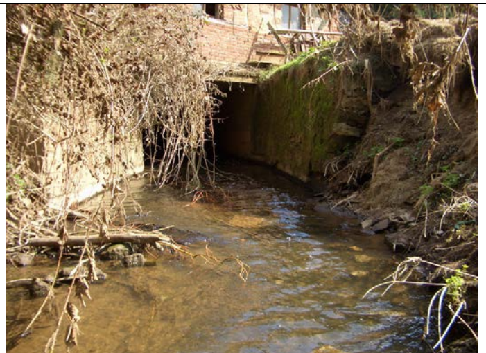
Auslauf Wasserkraftanlage Mühle Thetard
