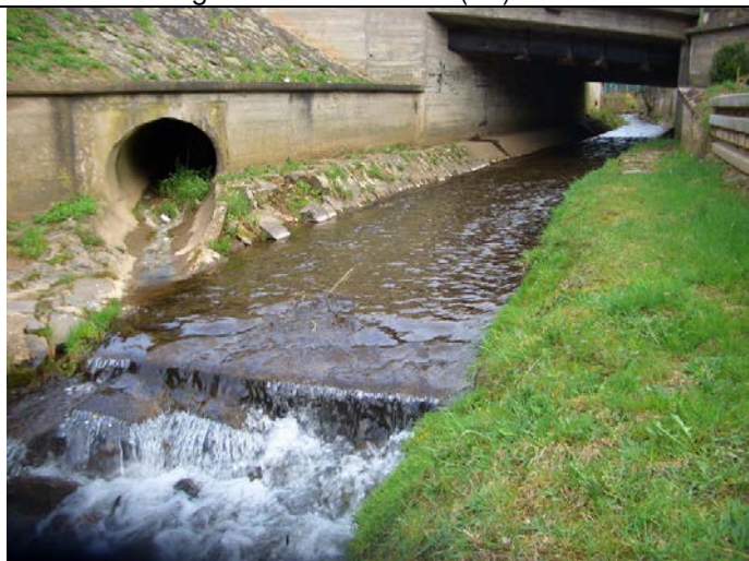
Absturz unterhalb Straßenbrücke B269 in Ortslage mit Mündung Verrohrung → Eintrag von Schmutzfracht war deutlich zu erkennen
