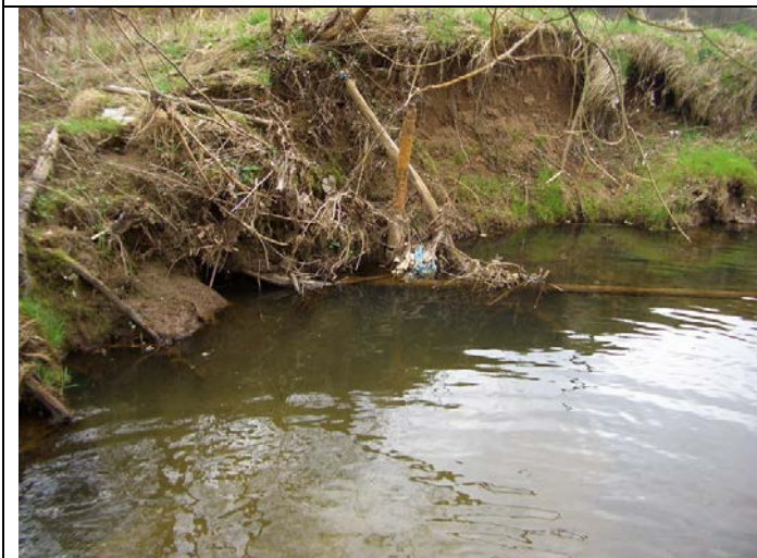
freigespülte Wasserleitung durchquert Gewässer
