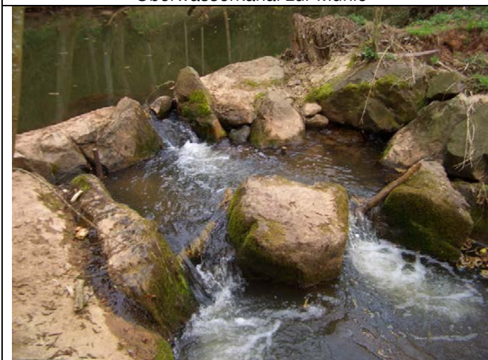
Anbindung Oberwasser Fischpass (zugesetzt, zu schmal)
