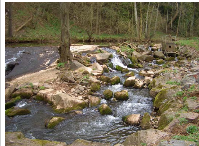
Fischpass in Blickrichtung Oberwasser mit Fangreuse
