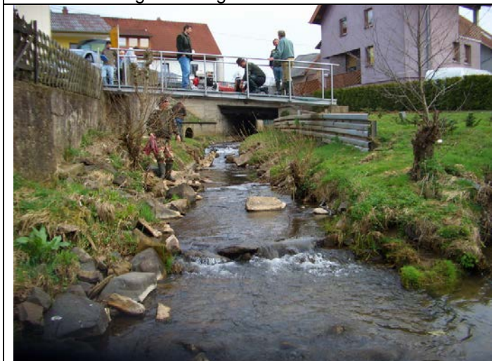
Abschnitt oberhalb Theel-Bach Mündung mit gemauerten Uferbacken und Betteinengung
