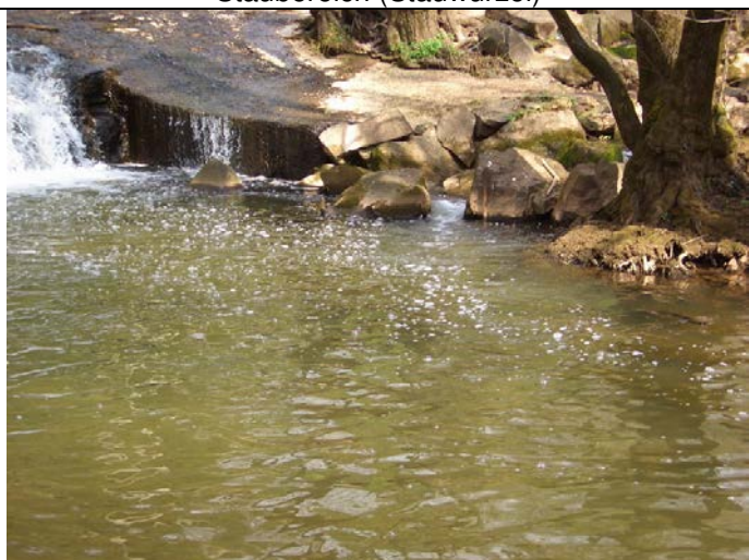
Auslauf Fischpass in Restwasser → Lockströmung sichtbar, aber zu gering
