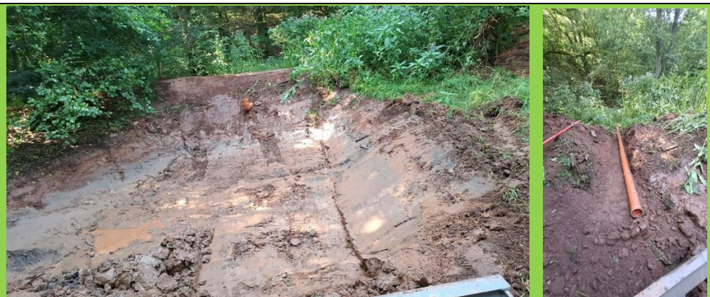
Am 03.08.2026 wurde ein neuer Überlauf in den künstlichen Damm gebaut und die Fläche ausgebaggert.
